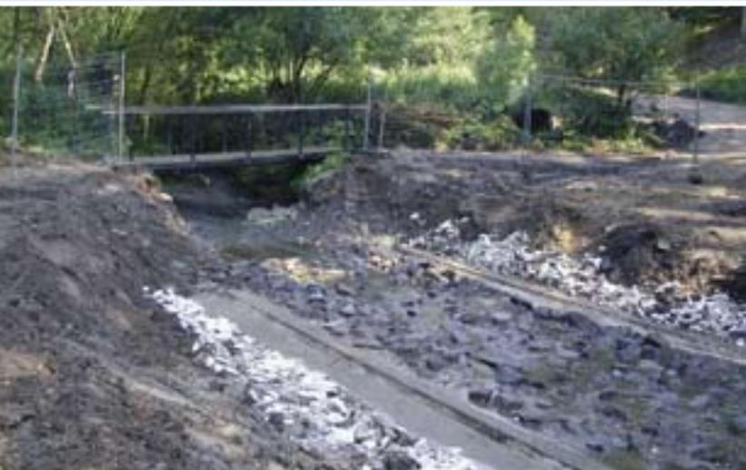
Betonierte Durchfahrten (*Furten*) wurden durch belastbare Brücken ersetzt und enge Rohre unter Wegen wechselte man gegen breitere, tiefer gelegte Durchlässe aus. Dort besteht das Bachbett jetzt wieder durchgehend aus natürlichem Substrat, z.B. Fels, Kies und Sand. Pflanzen und Tiere der Fließgewässer erobern den neu geschaffenen Lebensraum schnell zurück.
