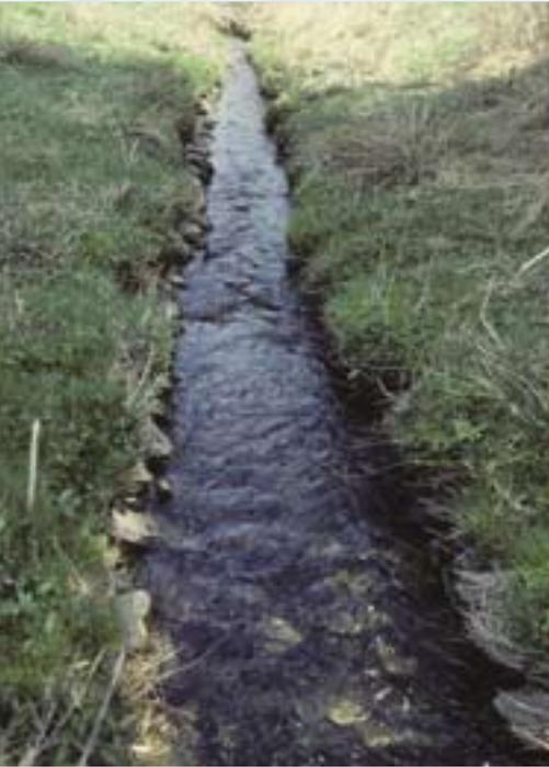
Viele Bachabschnitte wurden früher mit Steinpackungen massiv befestigt. Man wollte verhindern, dass der Bach stetig seinen Lauf veränderte, auf diese Weise Nutzungsgrenzen verschob oder Wege gefährdete. Unbeabsichtigt beschleunigte man dadurch den Wasserabfluss und minderte die Selbstreinigungskraft. Pflanzen, die früher in Kies und Lehm einen idealen Wuchsplatz hatten, fanden in den gepflasterten Böschungen keinen Raum mehr.
