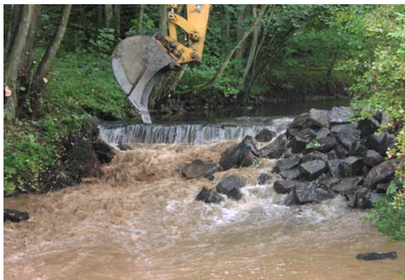
Abriss des Oberen Wiesenwehres im September 2003
