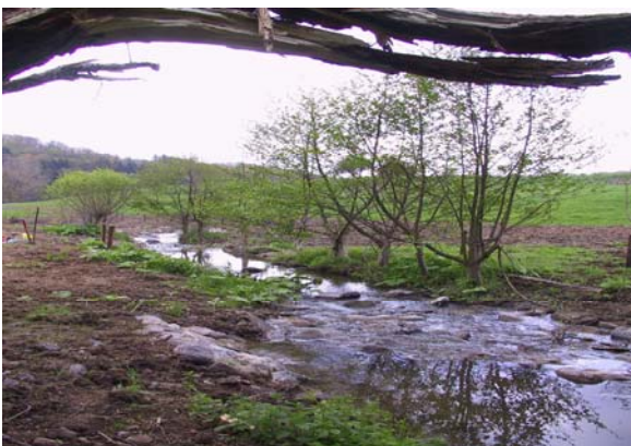
Nach Rückbau der Staustufen wurde die Wasserentnahme neu geregelt und das Bachbett der Ahr (linkes Bild) und des Mülheimer Bachs (rechtes Bild) unterhalb der ehemaligen Stauanlagen neu gestaltet.
